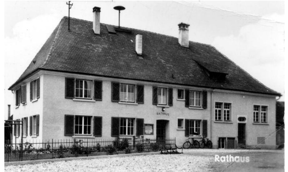
Abb. 14: Rathaus mit Lehrerwohnung im 1. Stock und Proberaum im rechten Gebäudeteil (Q16)
