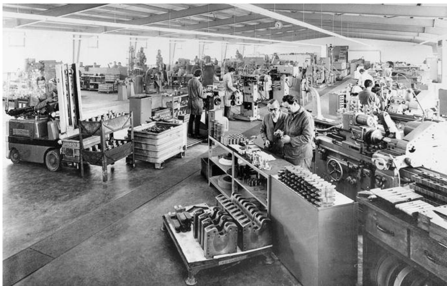
Abb. 39: Fertigungshalle der Fa. Maier Spannzeuge (Q2)
