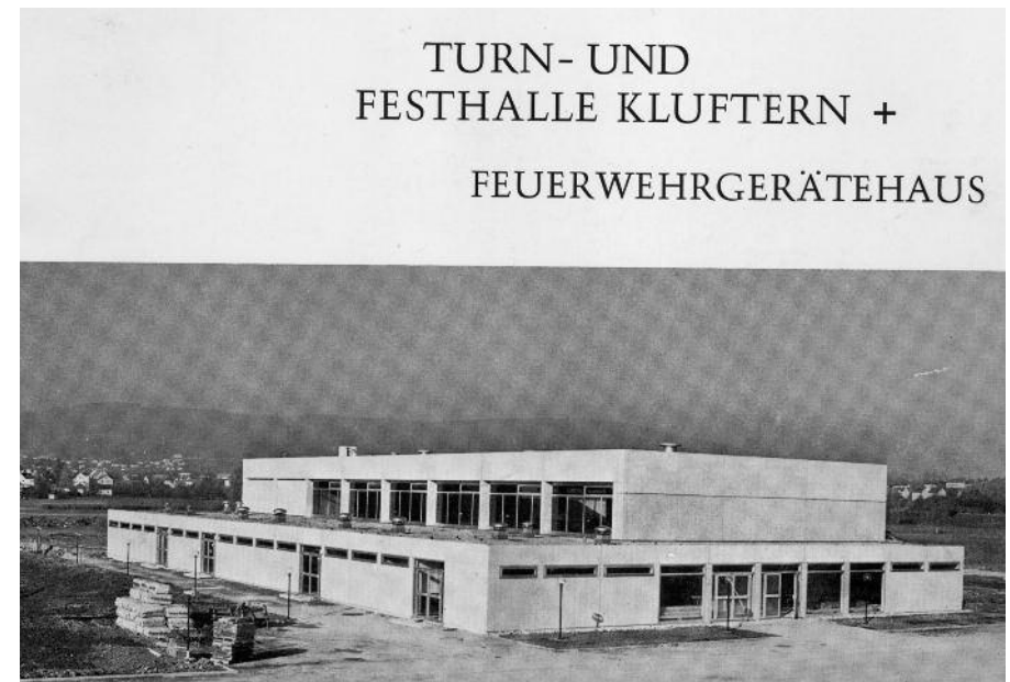
Abb. 60: Mehrzweckhalle Kluftern 1973 (Q15)
