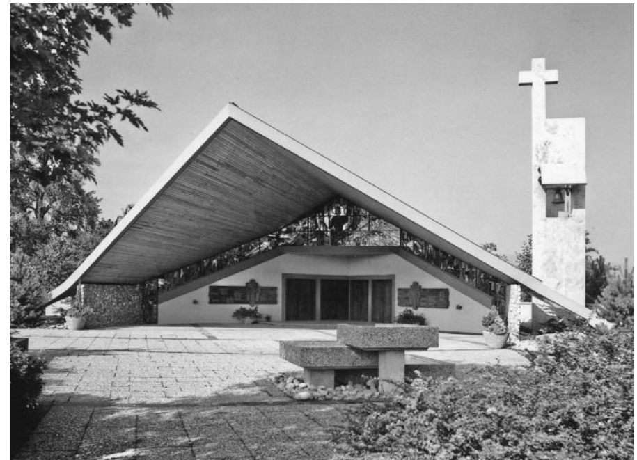
Abb. 26: Neue Einsegnungs- und Leichenhalle, 1968/69 (Q8)
