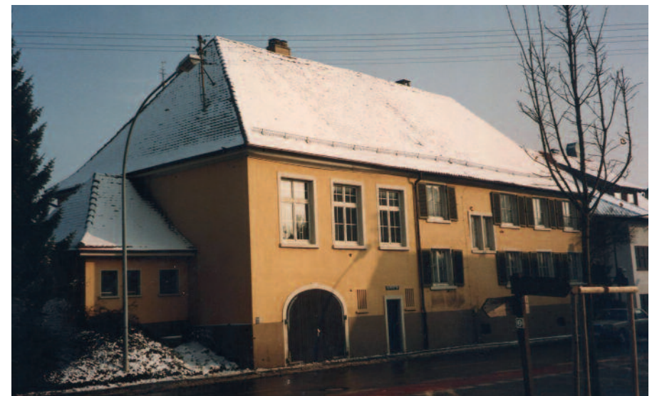
Abb. 48: Das alte Rathaus mit dem Proberaum für den Musikverein im ehemaligen Schulzimmer und dem Feuerwehr-Geräte Raum im Keller (Q11)
